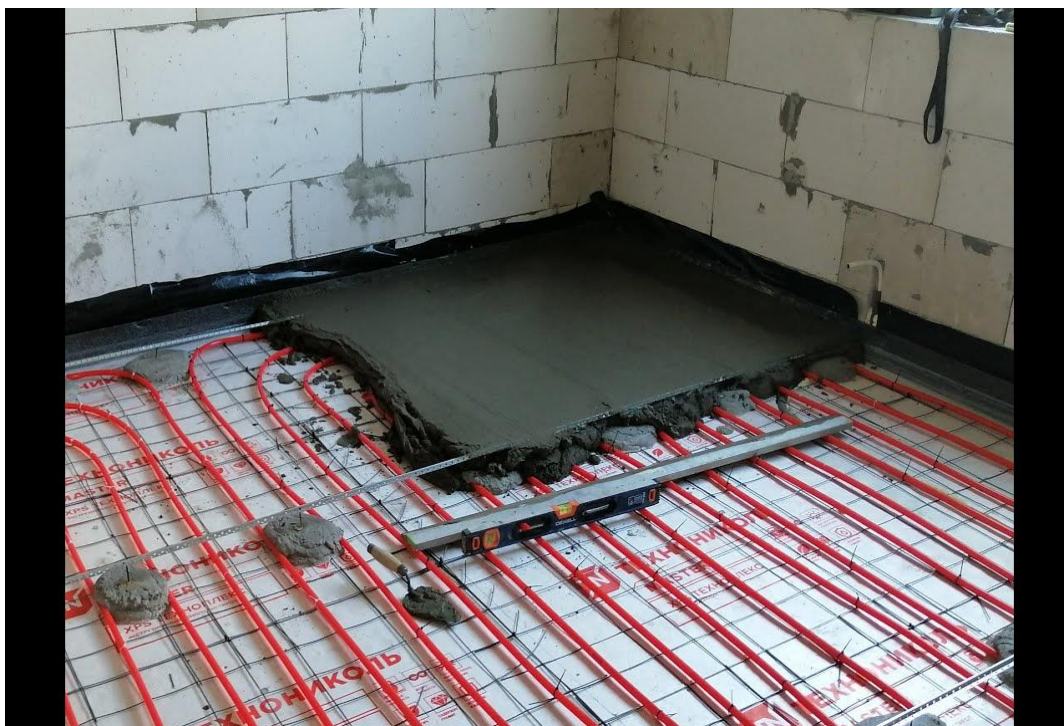
Рисунок 4 - использование термальной воды в напольном водяном отоплении (фото из интернета)
